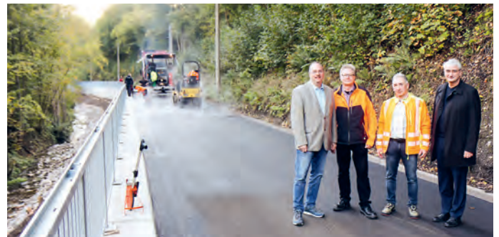
Bürgermeister Robert Geheeb, Marko Schoenheyd, Sachgebietsleiter Tiefbau, und Sachbearbeiter Lutz Meckel machten sich mit Landrat Marko Wolfram auf der K162 ein Bild von den Arbeiten. (Foto: P. Lahann)
