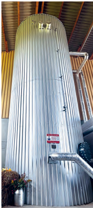
Herzstück der Nahwärmeversorgung für die Regelschule Neusitz ist der gigantische 60.000-Liter-Pufferspeicher. Von hier wird die Wärme über Plattentauscher an die Schule übergeben. Landrat Marko Wolfram und Uhlstädt-Kirchhasels Bürgermeister Frank Dietzel waren Gäste bei der offiziellen Inbetriebnahme der Anlage. Die Regelschule gestaltete ein kulturelles Rahmenprogramm. (Fotos: Carolin Schreiber)
